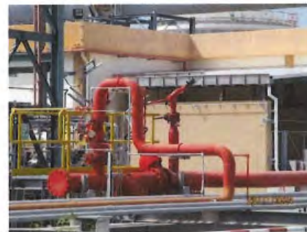
ภาพที่ 2-37 ระบบดับเพลิงบริเวณอาคารขนถ่ายผลิตภัณฑ์
