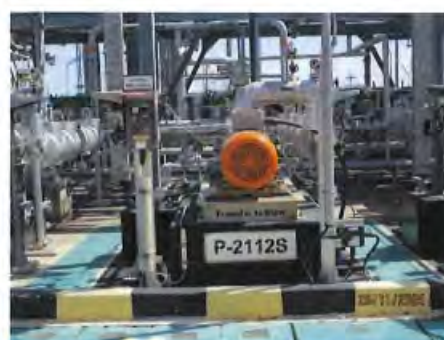
ภาพที่ 2-11 ฐานคอนกรีตเสริมเหล็กเพื่อลดแรงสั่นสะเทือน
