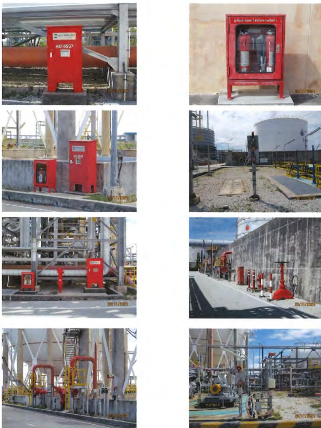
ภาพที่ 2-48 ระบบเตือนเหตุอัคคีภัยและอุปกรณ์ดับเพลิงภายในพื้นที่โครงการ
