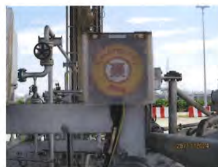
ภาพที่ 2-45 ปุ่ม Emergency Shutdown
