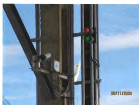
ภาพที่ 2-42 ไฟสัญญาณเพื่อแสดงสถานะพร้อมจ่ายผลิตภัณฑ์
