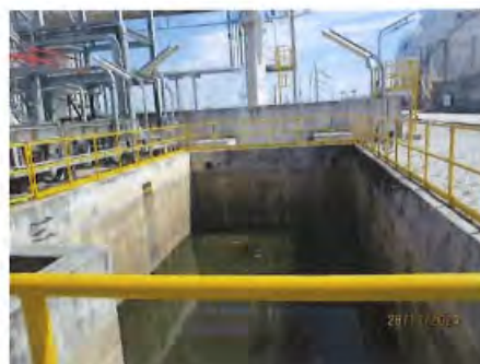
ภาพที่ 2-17 บ่อพักน้ำทิ้งฉุกเฉิน
