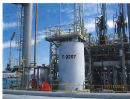
ภาพที่ 2-15 ถังรองรับน้ำเสียจากเรือ บนขานชาลาขนถ่ายผลิตภัณฑ์
