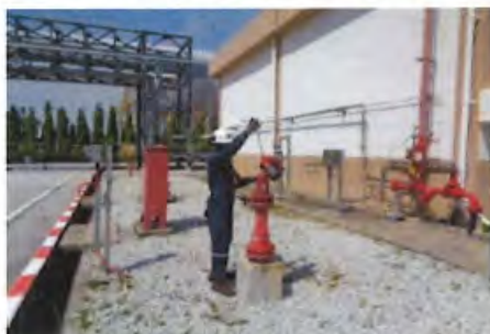
ภาพที่ 2-33 การตรวจสอบระบบป้องกันอัคคีภัย
