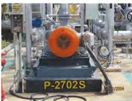
ภาพที่ 2-11 ฐานคอนกรีตเสริมเหล็กเพื่อลดแรงสั่นสะเทือน
