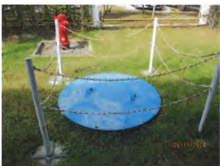
ภาพที่ 2-14 บ่อพักน้ำทิ้งขนาดเก็บกักได้ 1 วัน
